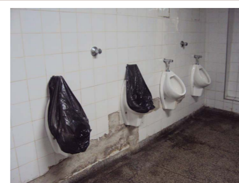
Banheiro PAT - Rangel.
